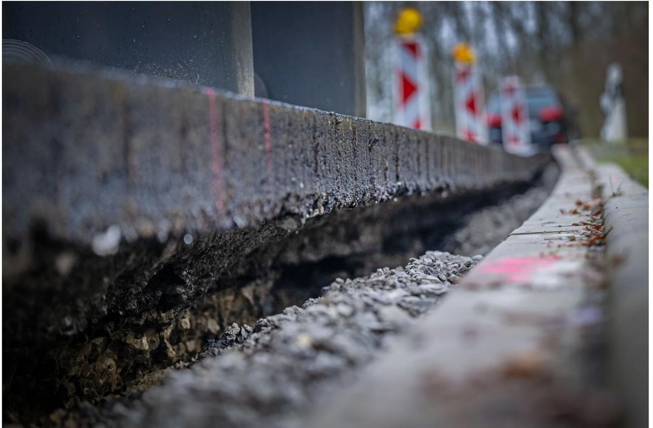
Die gerade erst erneuerte Asphaltdecke auf der Selhausenstraße blieb teilweise stehen, der Boden darunter gab bis zu zwei Meter nach und rutsche senkrecht in den Untergrund ab. Foto: Thomas F. Starke
